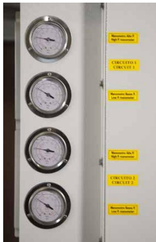
Manometri circuito frigorifero - Refrigerant gauges
